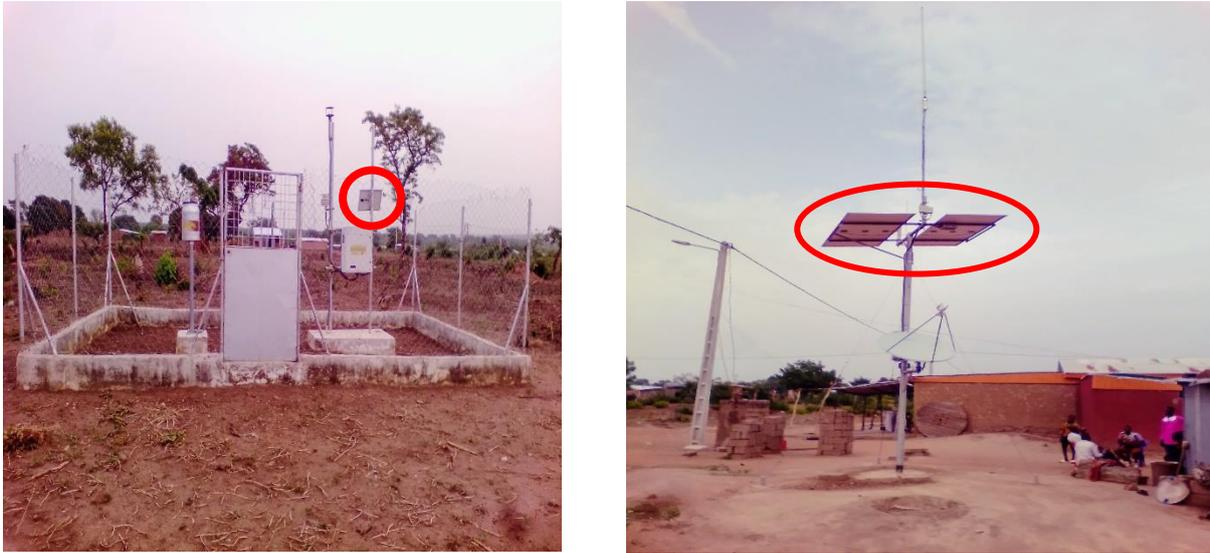
**Figure 4** : Panneaux solaires de la station météorologique et du réseau MTN (Goula, 2024)
