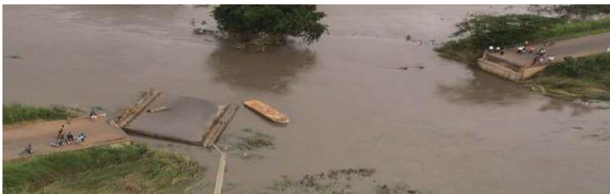
Photo 10: Aperçu du pont sur la route nationale N°1 à AMAKPAPE coupé (SNRR)
