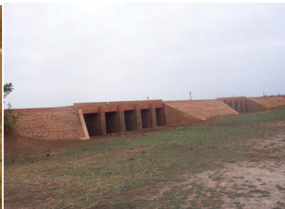
Vue de l'« ouvrage double/pont-barrage » opérationnel (non lu) de Baye
