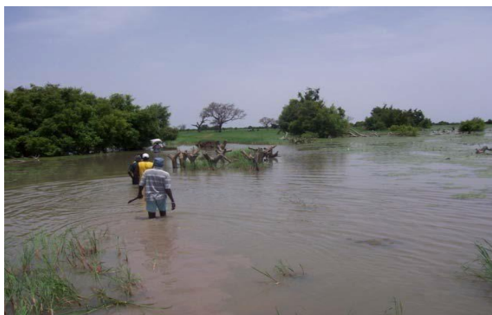
Figure 1 : Vue de la retenue du Sourou en aval /nord de Baye en période crue (aval de l'« ouvrage double »)
